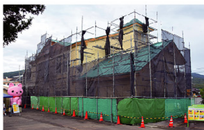
建設中の「つくば国際ペット専門学校附属動物医療センター」(つくば市沼田)
