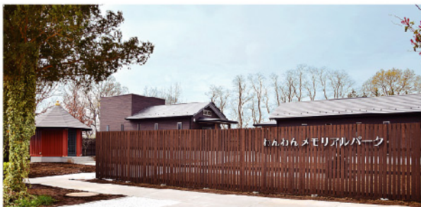
施設を一新してオープンした「わんわんメモリアルパーク」(一部工事中)
